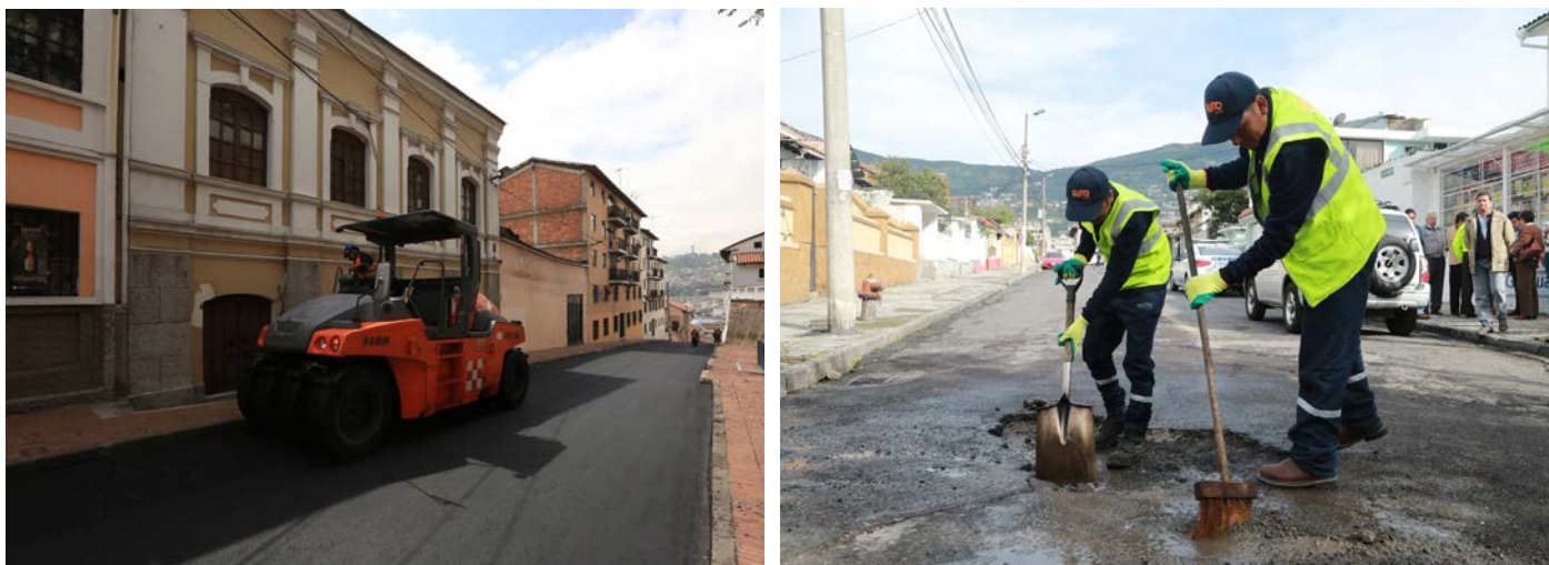
Foto: Programa de Rehabilitación y Mantenimiento Vial
