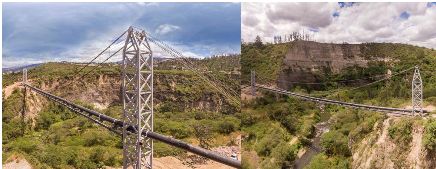
Fotos: Pasos elevados de agua
